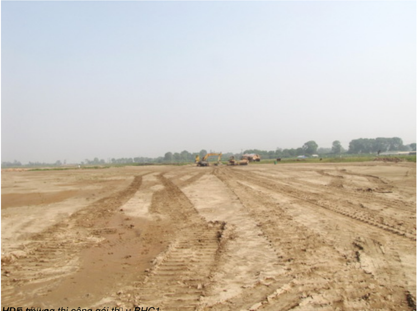
MDF-trên sg thi công gói thầu BHC1
