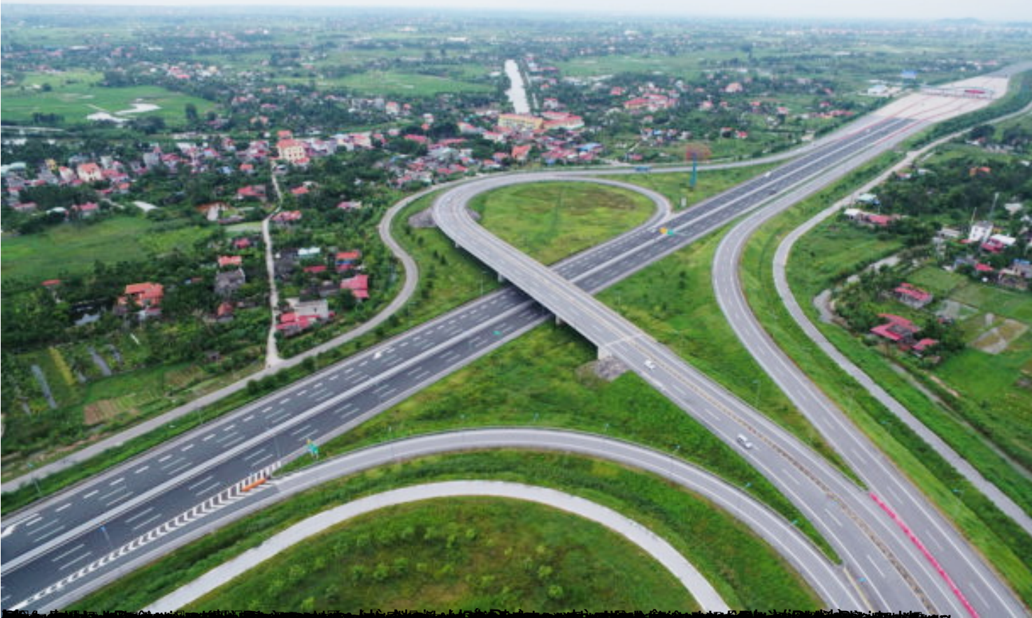
Đường cao tốc mới được xây dựng và hoàn thiện, kết nối các khu vực phát triển kinh tế.
