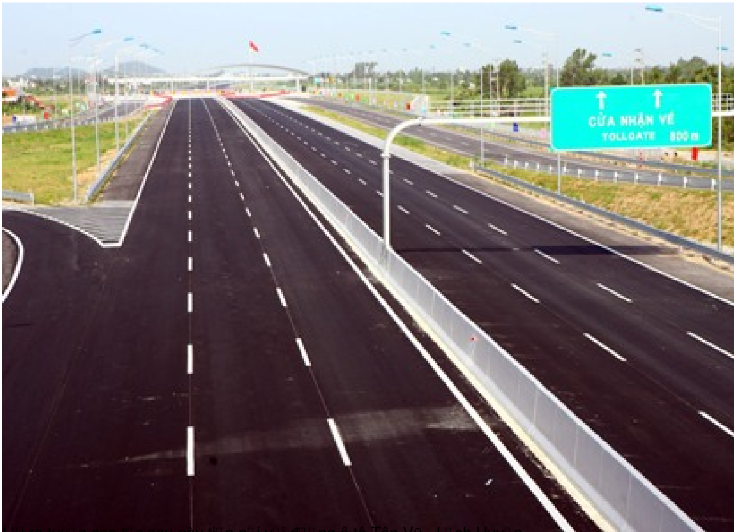
Đường cao tốc mới sau này tiếp nối với đường ô tô Tân Vũ - Lạch Huyện
