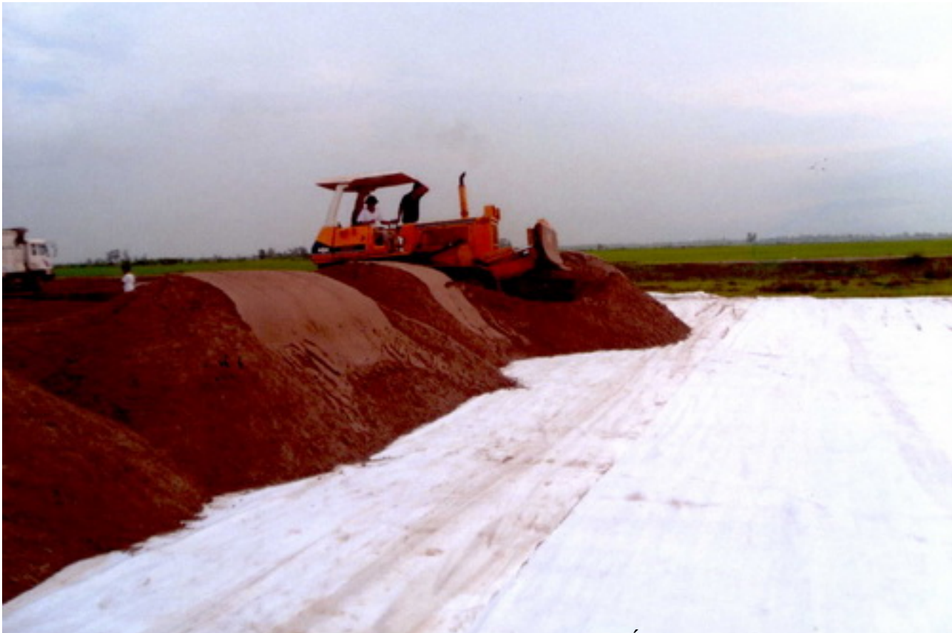
Hình ảnh 006: Công nhân đang thi công đắp nền đường ô tô cao tốc Hà Nội - Hải Phòng, Công đoạn thi công đắp nền đường ô tô cao tốc Hà Nội - Hải Phòng.
