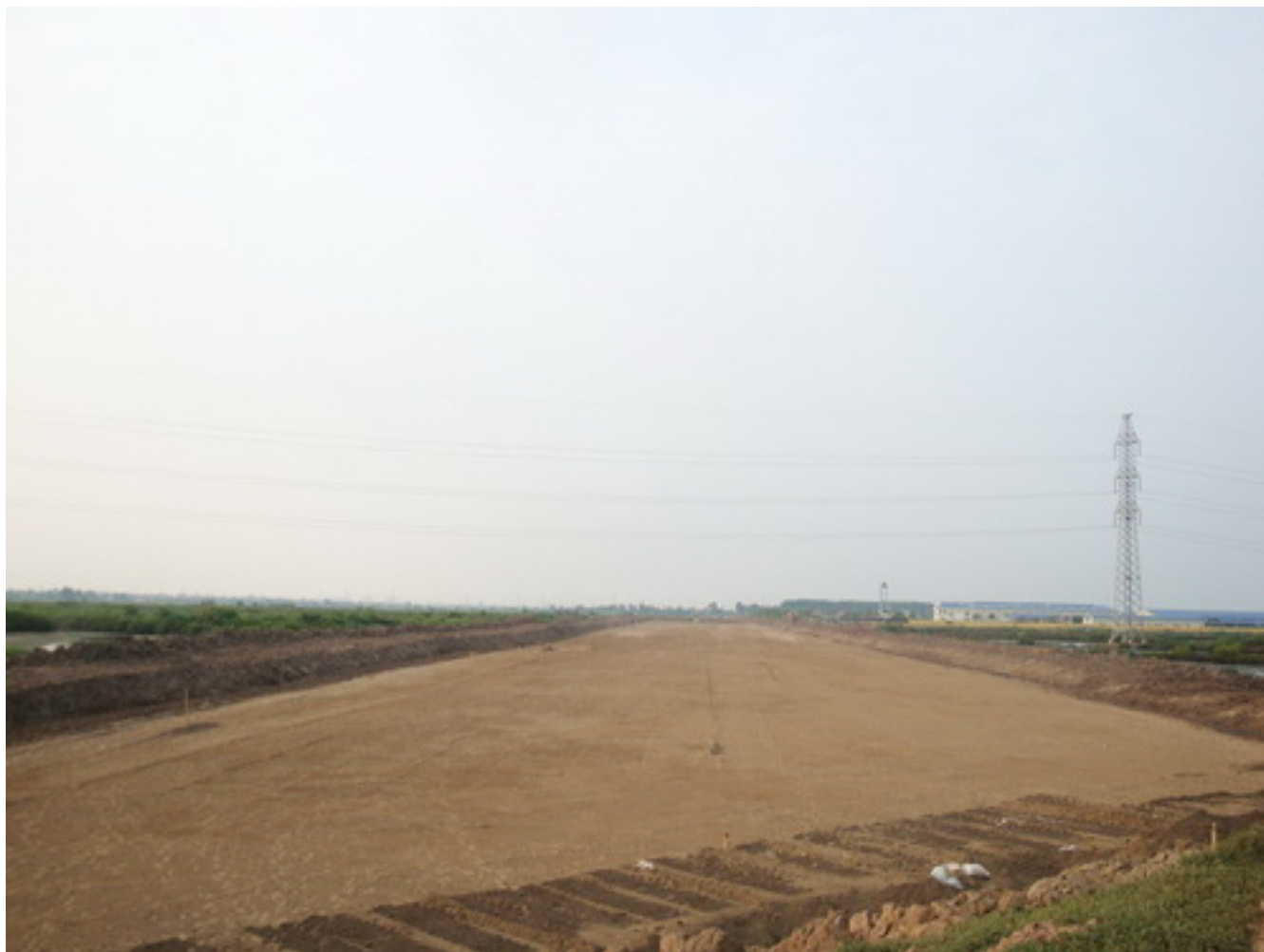
Hình ảnh thi công gói thầu EX10 - dự án đường ô tô cao tốc HN-HP
