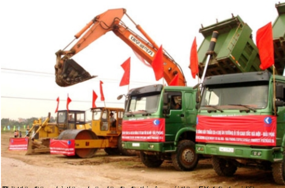
Vận tải được nhà thầu chuẩn bị để thi công gói thầu EX-4 (nh: vidifi)
